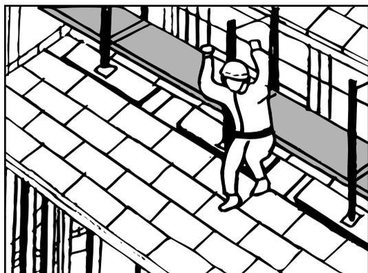
作業中、足場から屋根面へ跳びおりたり、物を落としたりするとひび割れ、破損を生じ、雨漏り等のクレーム原因となりますので注意して下さい。
