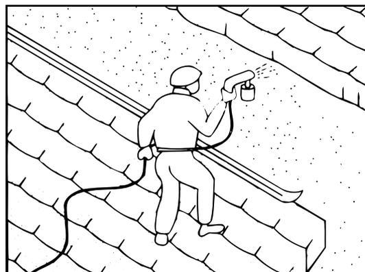
壁面、その他モルタル塗り、リシン吹きつけなどの吹付作業に際しては、屋根面のシート養生を徹底するよう指示をしてください。
