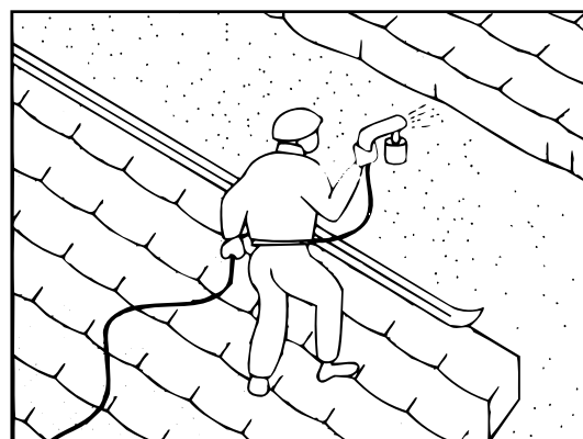
④ 壁面、その他モルタル塗り、リシン吹きつけなどの吹付作業に際しては、屋根面のシート養生を徹底するよう指示をしてください。
